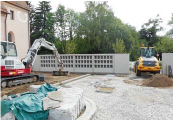
Ein Teil der Urnenwände ist bereits aufgestellt
