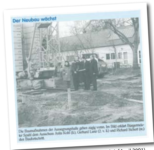
Neubau der Aussegnungshalle (bürgerbrief April 2001)
