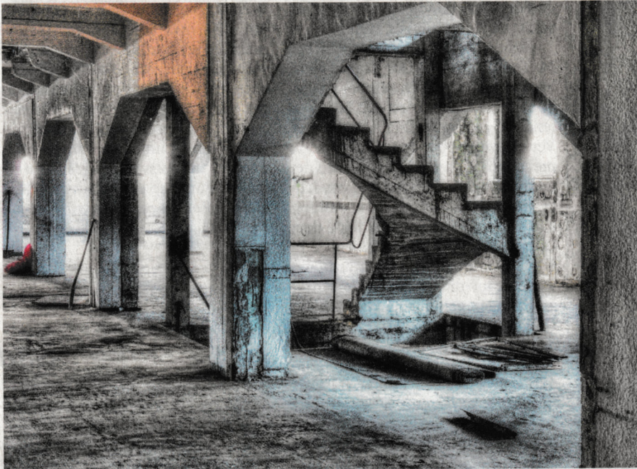
Eine Innenansicht des WLZ-Gebäudes.
